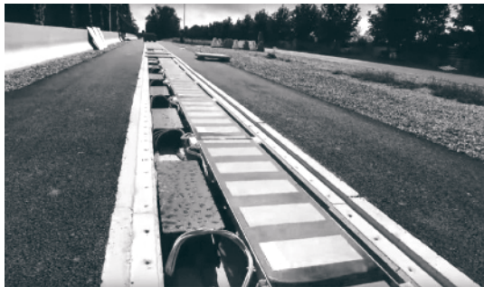
Sistema para cargar un vehículo eléctrico de la empresa Qualcomm.
