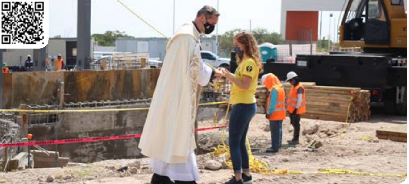
Bendición del inicio de obra, octubre 2021.
